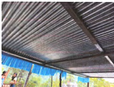
Foto 2: Sustrucción de estructura metálica para soporte de cubierta de lámina incluyendo perfiles para vigas, travesaños, sujeta con tornillería; corte, soldadura y anclaje de la estructura portante.
