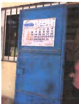
Foto 3: Mantenimiento a puerta metálica existente retiro de óxido, suciedad y pintura deteriorada; incluye cepillado, lijado y aplicación de pintura
