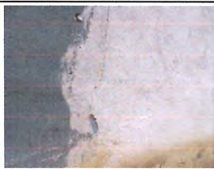
Foto 6: Reparación de repello y cernido en muro de mampostería con aplicación de acabado uniforme
